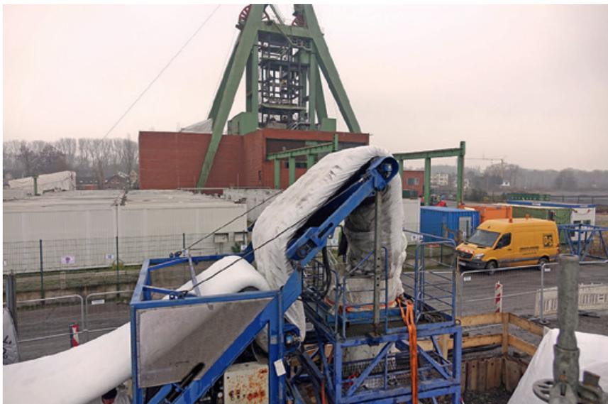
**Abb. 4** Vom Lkw aus wurde der Schlauchliner über ein Förderband zum Inversionsturm geführt.
